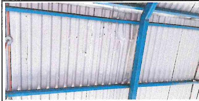
Foto 5: Sustitución de techo de lámina y reparación de sistema Eléctrico
